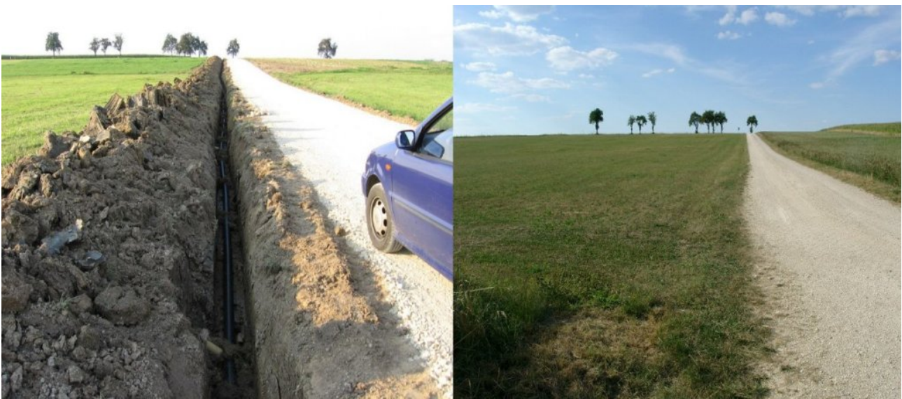
Abbildung 8: Beispiel der Trockenlegung einer landwirtschaftlich genutzten Wiese entlang eines Feldweges. Zur schwarzen großen Drainleitung entlang des Feldweges münden von links alle 15 Meter gelbe Saugleitungen, welche die Wiese trockenlegen, Die erste ist erkennbar. Im Sommer sieht die Wiese dann braungrüngelb aus mit spärlichem Grasbewuchs im August. (rechtes Bild). So erzeugt man sommerliche Steppen in Deutschland. Fotos Worm/Kowatsch.
